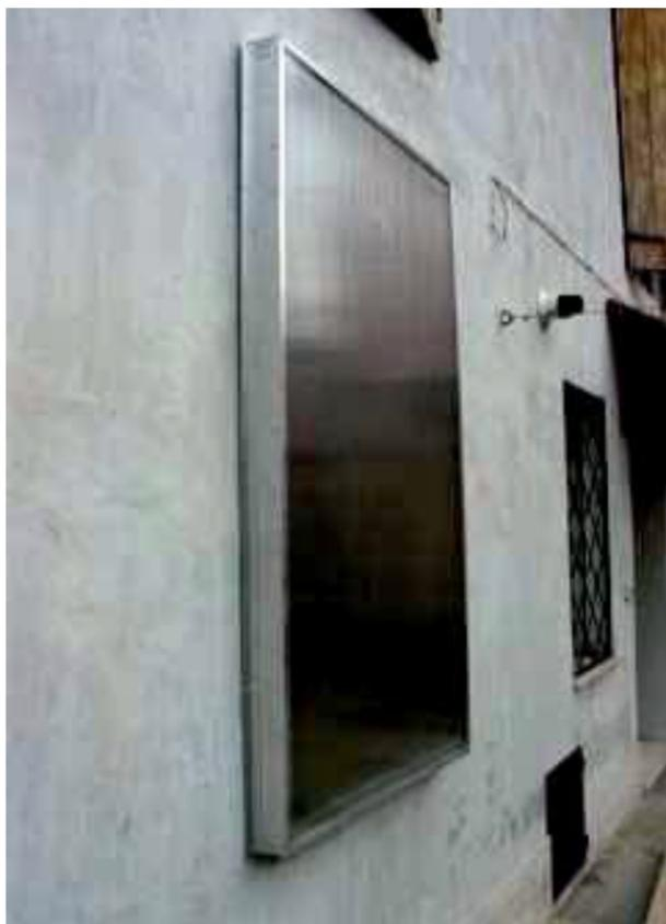
**Figura 1 – Thermoflow: il funzionamento del sistema è regolato da un controllore elettronico programmabile, fornito con il collettore. La superficie captante è realizzata senza l'impiego di vernici o sostanze che possano volatilizzare ed emettere esalazioni inquinanti di alcun tipo.**
