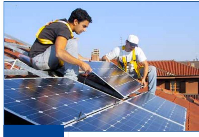
taici sono garanzia di efficienza, affidabilità e risparmio nel tempo (generalmente i pannelli solari vengono garantiti 25 anni, 10 anni con potenza pari al 90% e 25 anni con potenza all'80%). Ma che cos'è un impianto fotovoltaico a pannelli solari? Si tratta di un impianto che cattura la luce del sole e la trasforma in energia utilizzabile da tutti quegli apparecchi alimentati da corrente elettrica.
